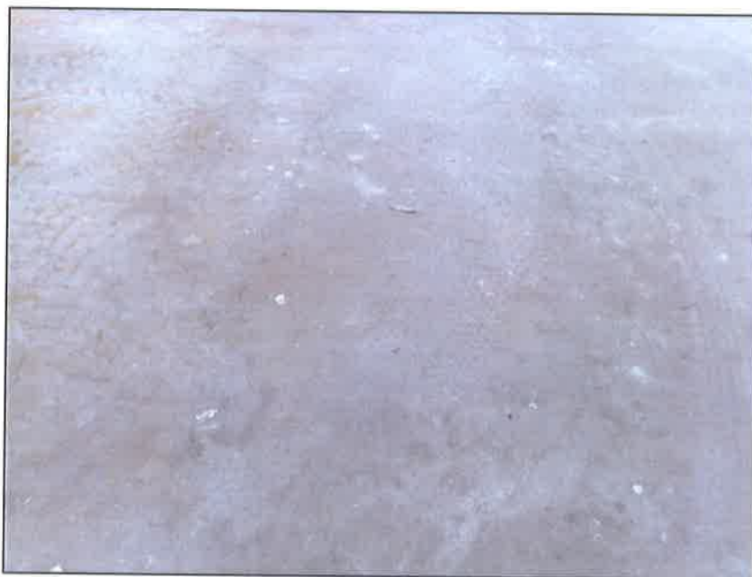
FIG.17 Particolare Pavimentazione ala W capannone esistente
